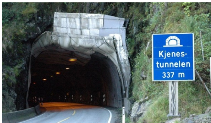
Tunnelisolasjon av hvite PE-plater
