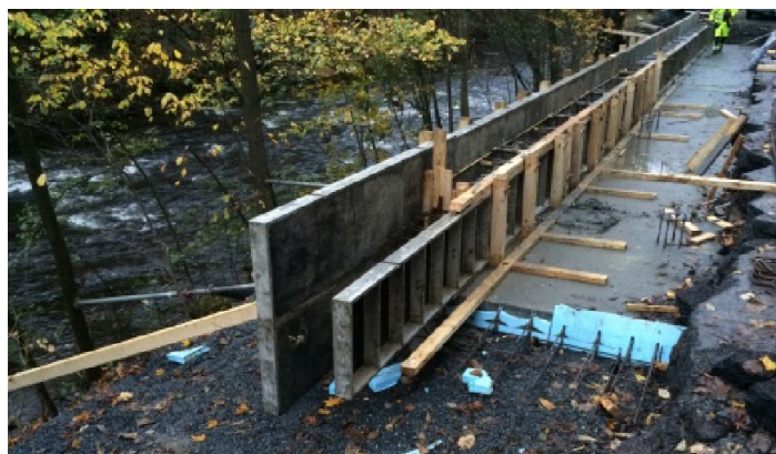
XPS-plater under betong i veg
